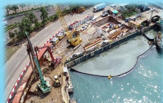
工程進行中 Construction in progress
