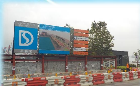
工程告示牌 Project Signboard
