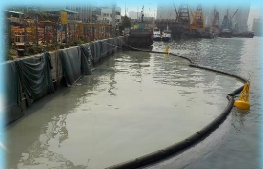
箱形雨水渠 Box Culvert
