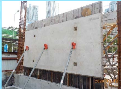
安裝預製組件 Installation of DfMA modules
