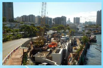
泵房與旱季截流器維修通道開始連接,旱季截流器內的機電設備,如抽風系統、電力系統和油壓系統亦已經開始安裝。還有,九個旱季截流器中的截流水閘已有八個完成安裝。
